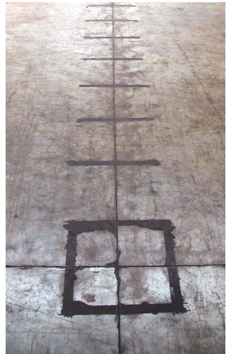
Sanierung eines Fugenschnittes durch nachträgliche Verdichtung.
