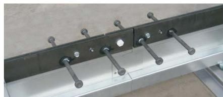
Stoßverbindung durch Kunststoffschraube
