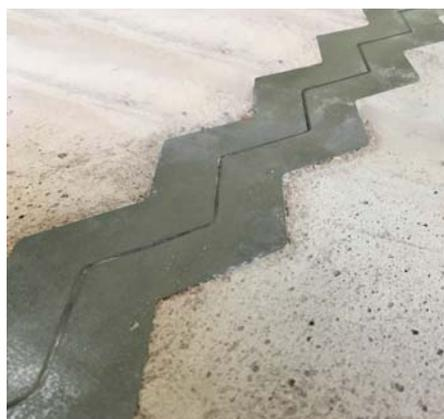
Fuge nach dem Betonieren
