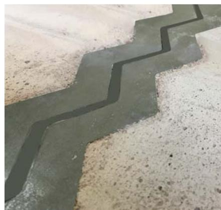
Fugenaufweitung nach dem Schwinden
